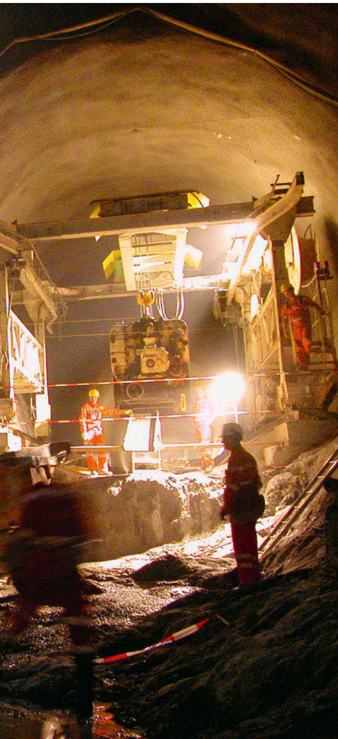
Ausbruch unter 2300 Metern Gestein und Innenausbau im Gotthard-Basistunnel
